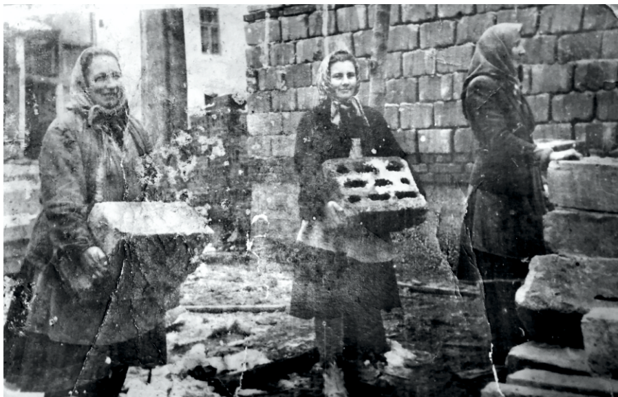
Výstavba obecného úradu
